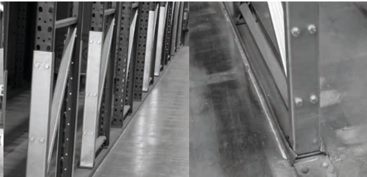
Reparatur eines Regalständers mittels einer Ständeraufschuhung.
